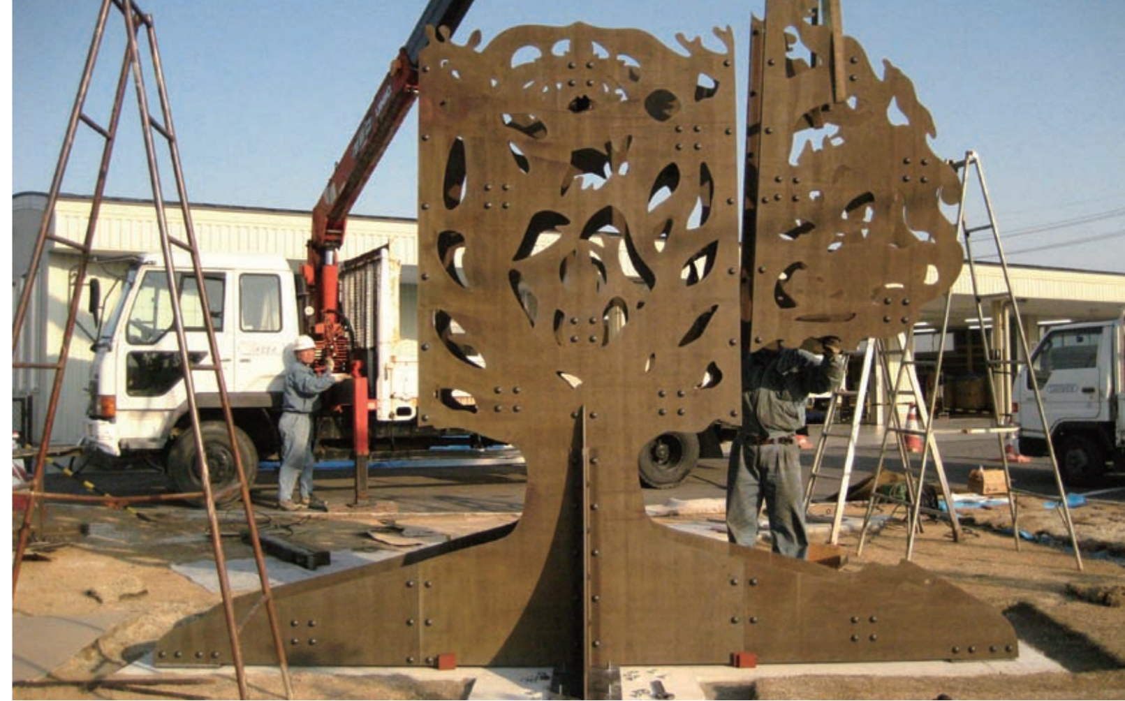
現地の設置作業
