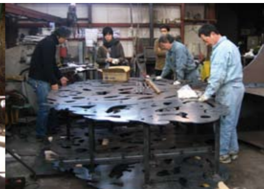
工場での仮組作業
